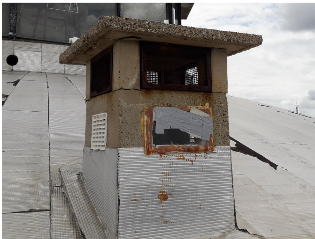
Photographie 85 : Désordre de type 4 - Vue de l'étanchéité en surface de la dalle haute de la cuve
