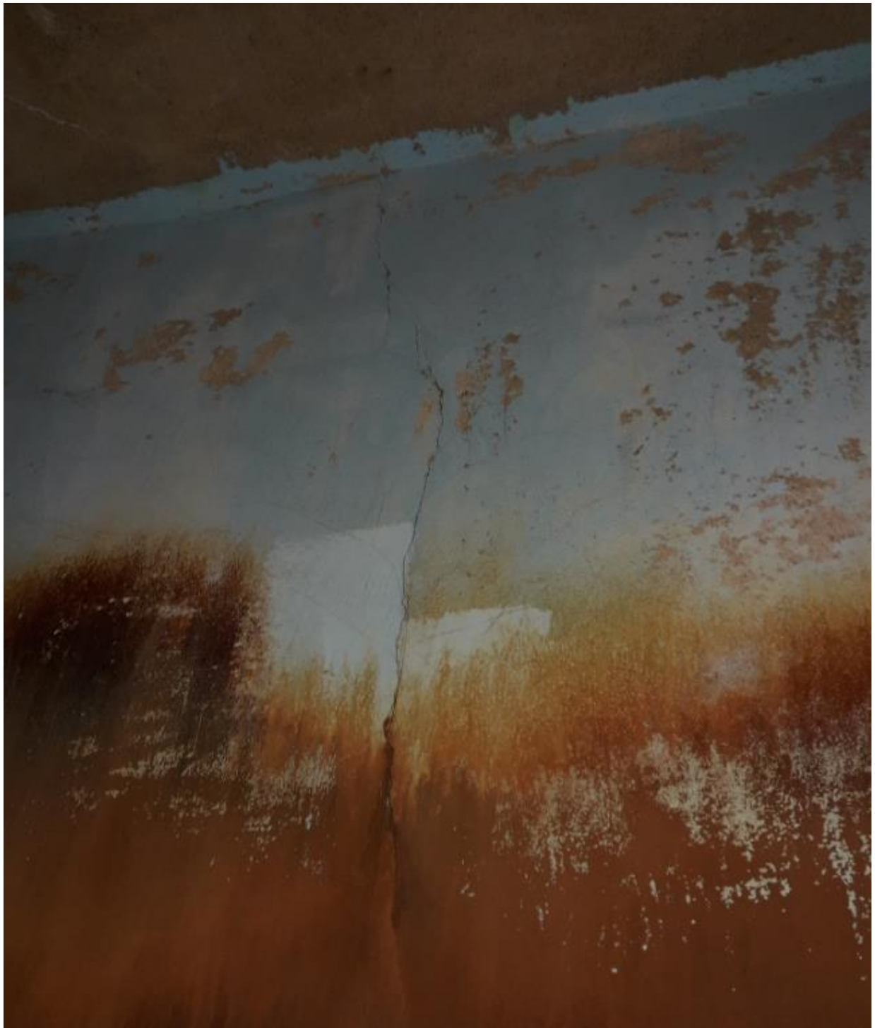
Photographie 64 : Désordres de type 3, 4 et 6 – Fissure verticale et dépôt de ferrite
