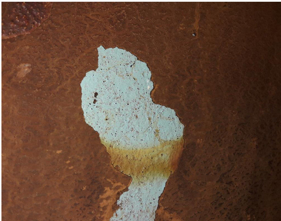
Photographie 62 : Désordres de type 3 et 6 – Légère fissure et dépôt de ferrite
