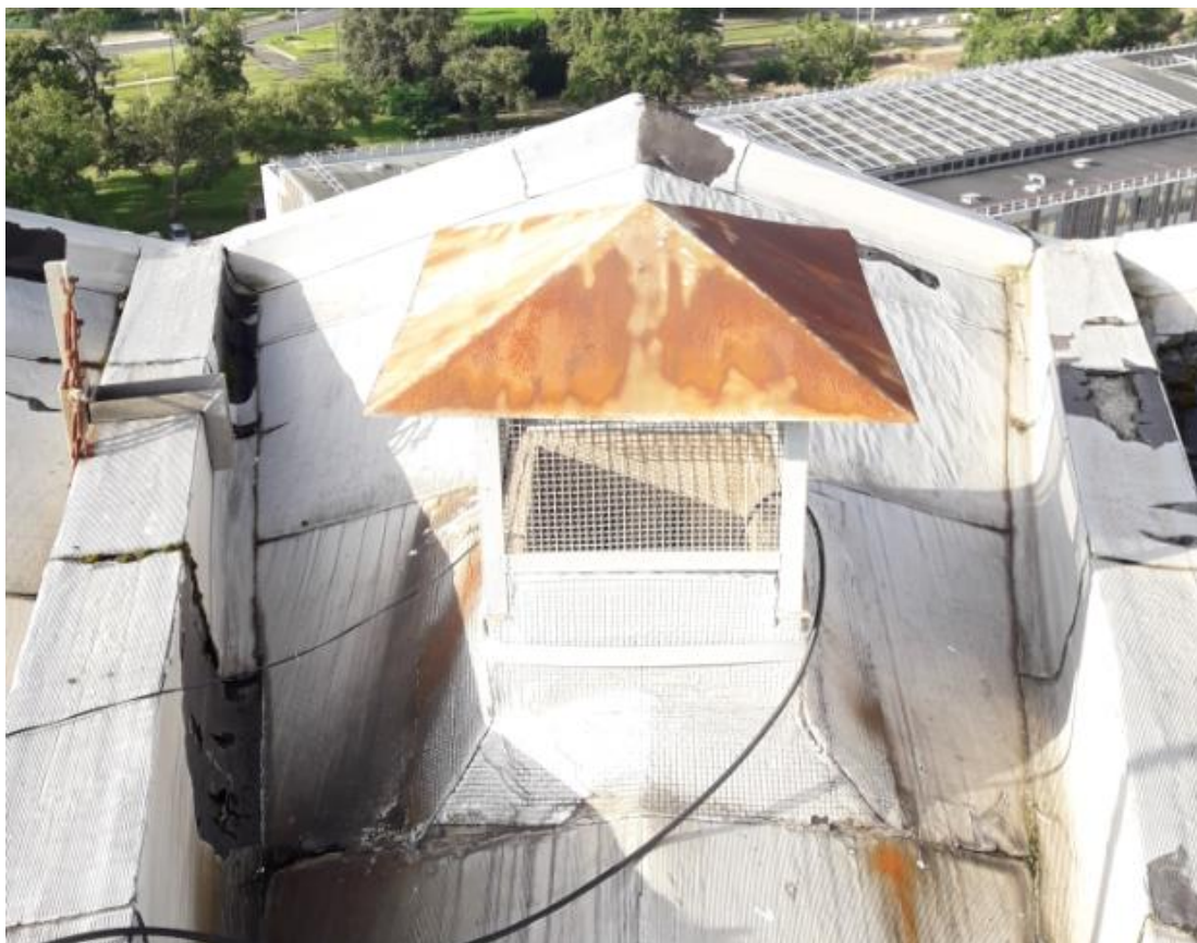
Photographie 93 : Désordre de type 4 - Vue de l'étanchéité en surface du toit du belvédère
