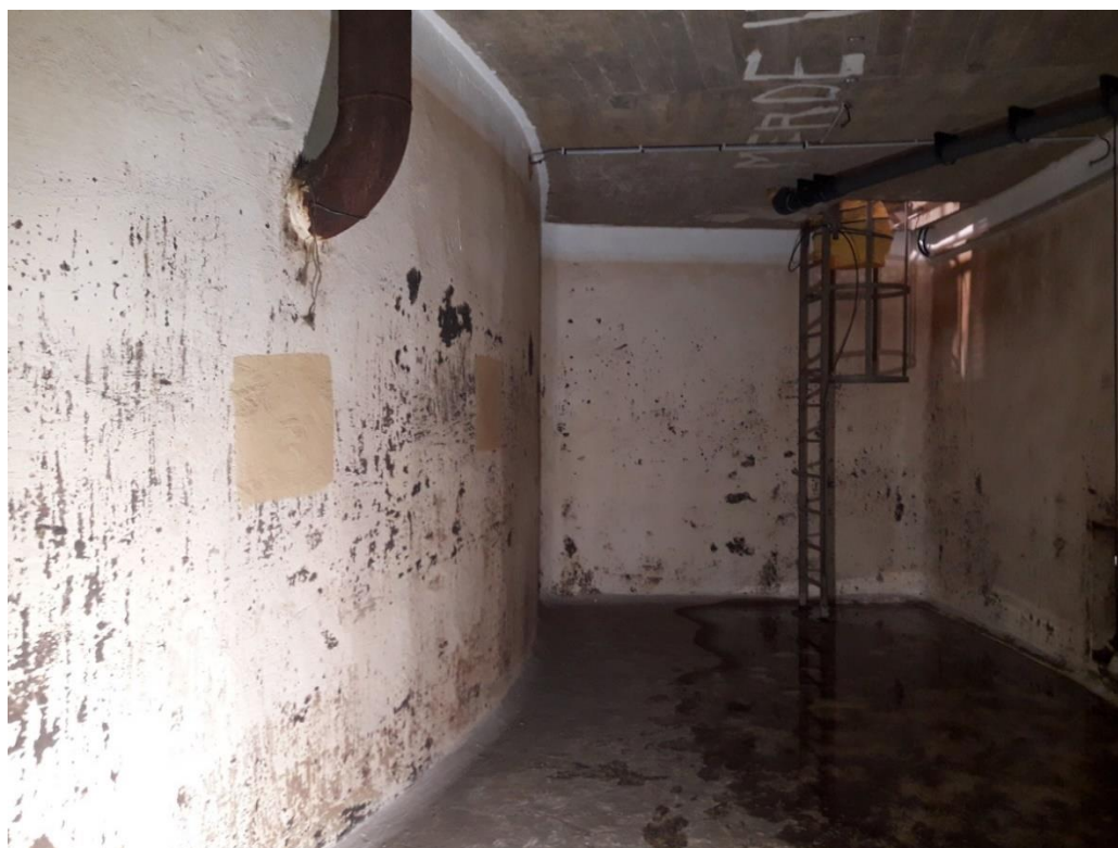
Photographie 55 : Désordres de type 4 et 6 – Dégradation de l'étanchéité et dépôt de ferrite
