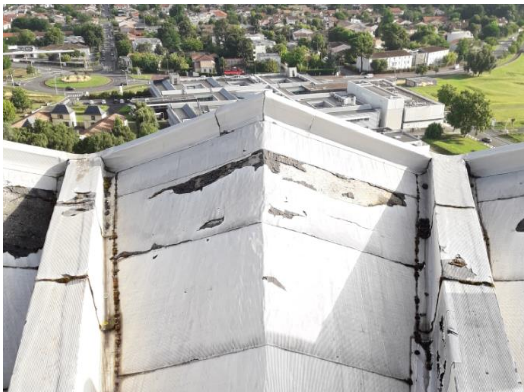
Photographie 90 : Désordre de type 4 - Vue de l'étanchéité en surface du toit du belvédère
