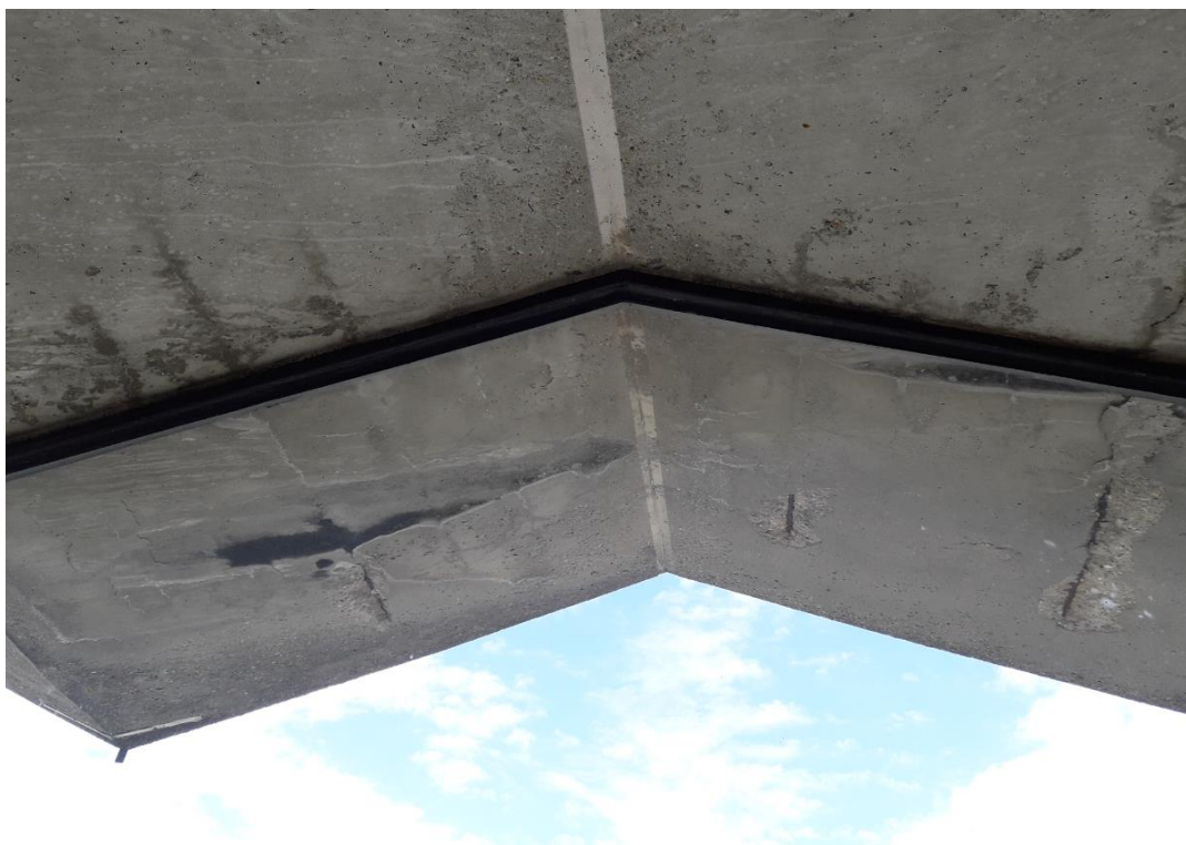
Photographie 95 : Désordre de type 1 – Sous-face du toit du belvédère
