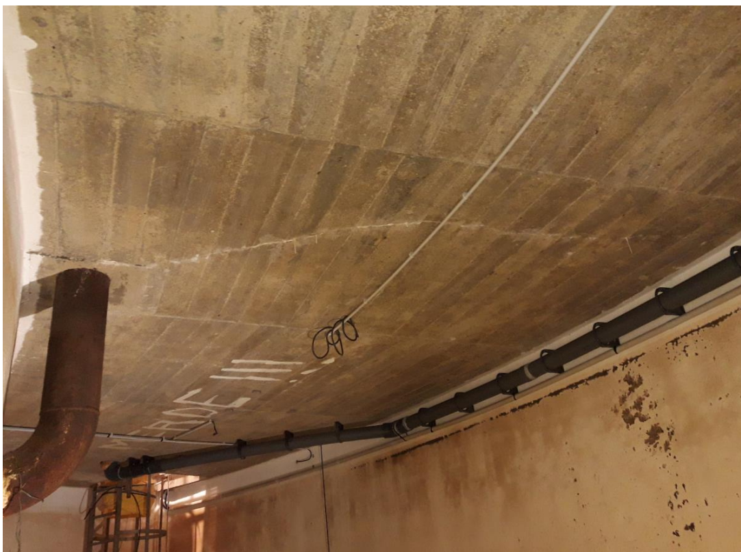
Photographie 58 : Désordres de type 2 et 3 – Fissure dalle haute de la bâche
