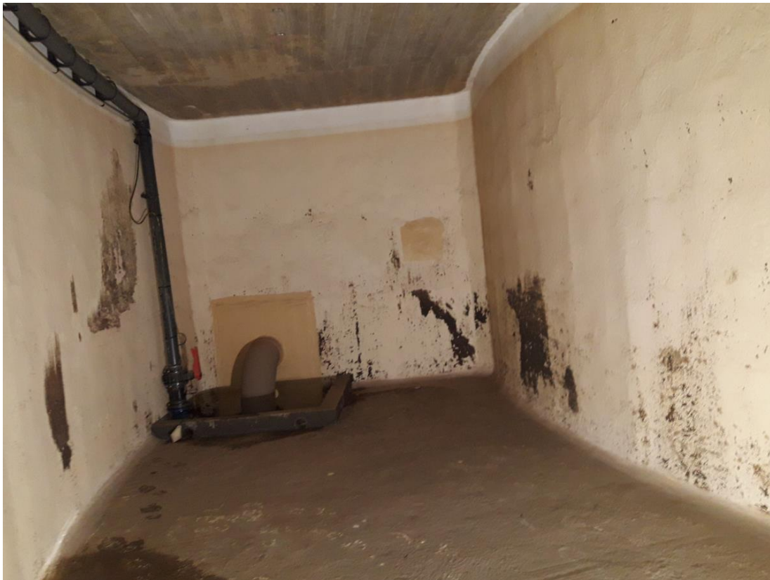
Photographie 56 : Désordres de type 4 et 6 – Dégradation de l'étanchéité et dépôt de ferrite
