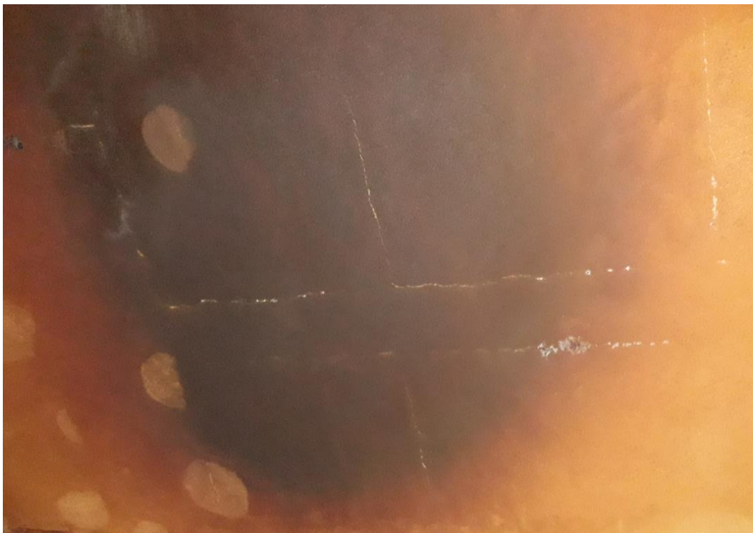
Photographie 50 : Désordres de type 4 et 6 – Cloquage de l'étanchéité et dépôt de ferrite
