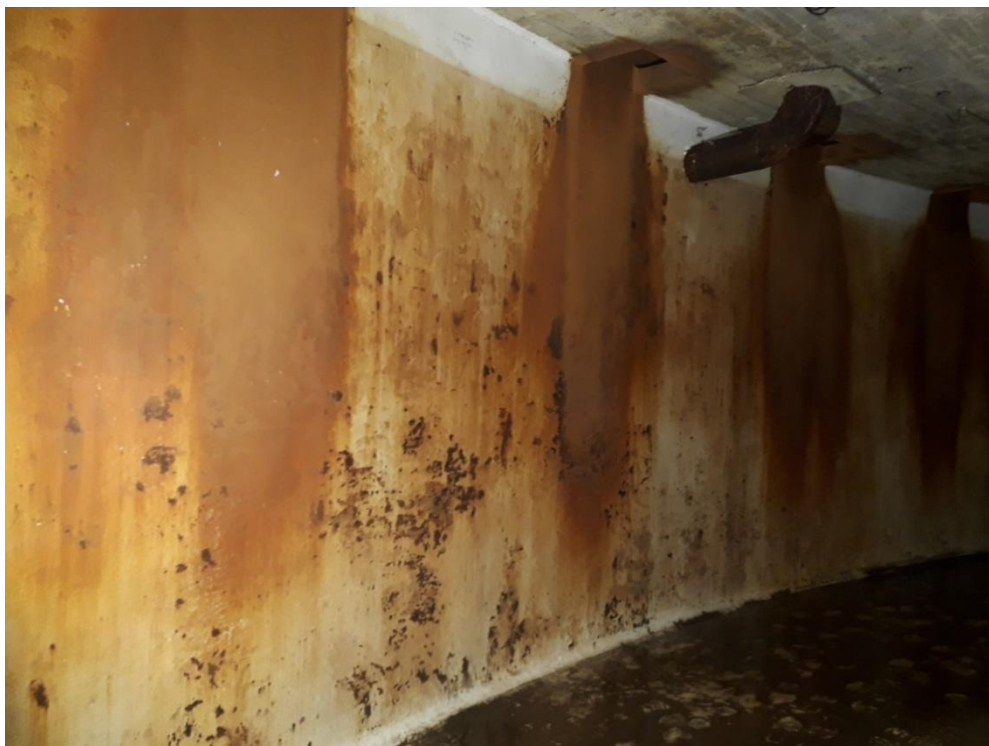
Photographie 53 : Désordres de type 4 et 6 – Dégradation de l'étanchéité et dépôt de ferrite
