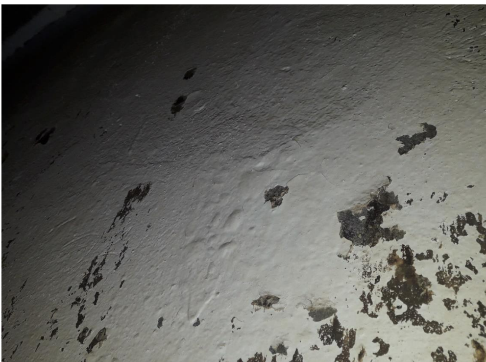
Photographie 42 : Désordre de type 4 – Cloquage et dégradation de l'étanchéité
