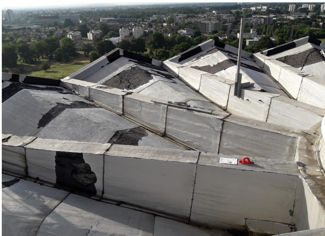
Photographie 89 : Désordre de type 4 - Vue de l'étanchéité en surface du toit du belvédère
