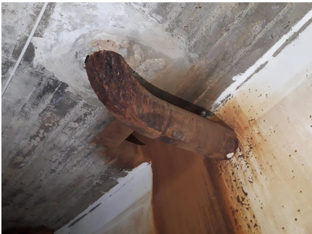
Photographie 43 : Désordre de type 5 – Conduite corrodée
