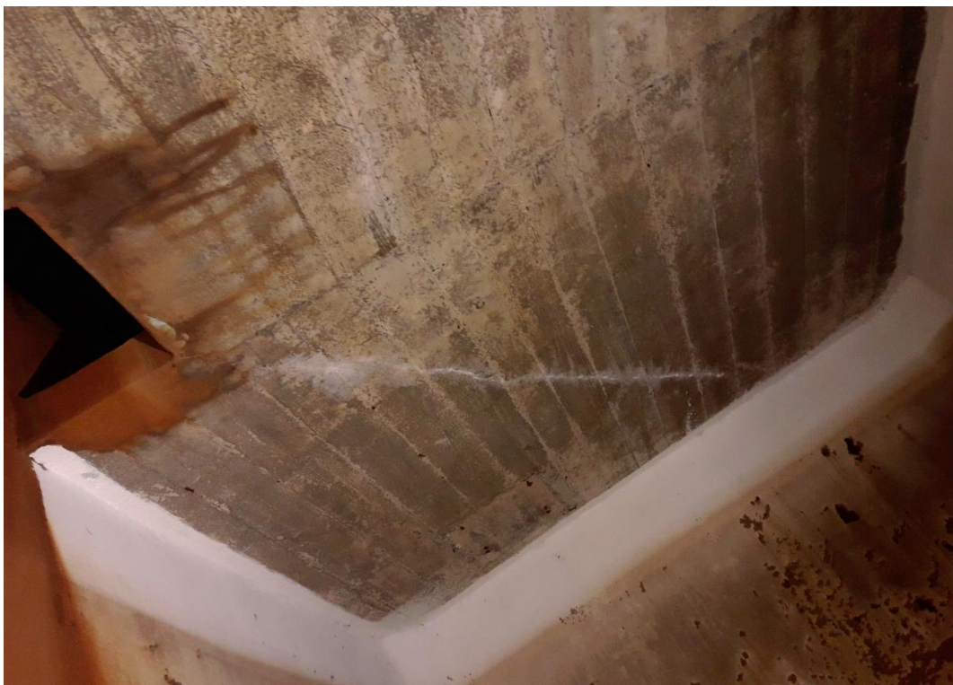
Photographie 57 : Désordres de type 2 et 3 – Fissure dalle haute de la bache
