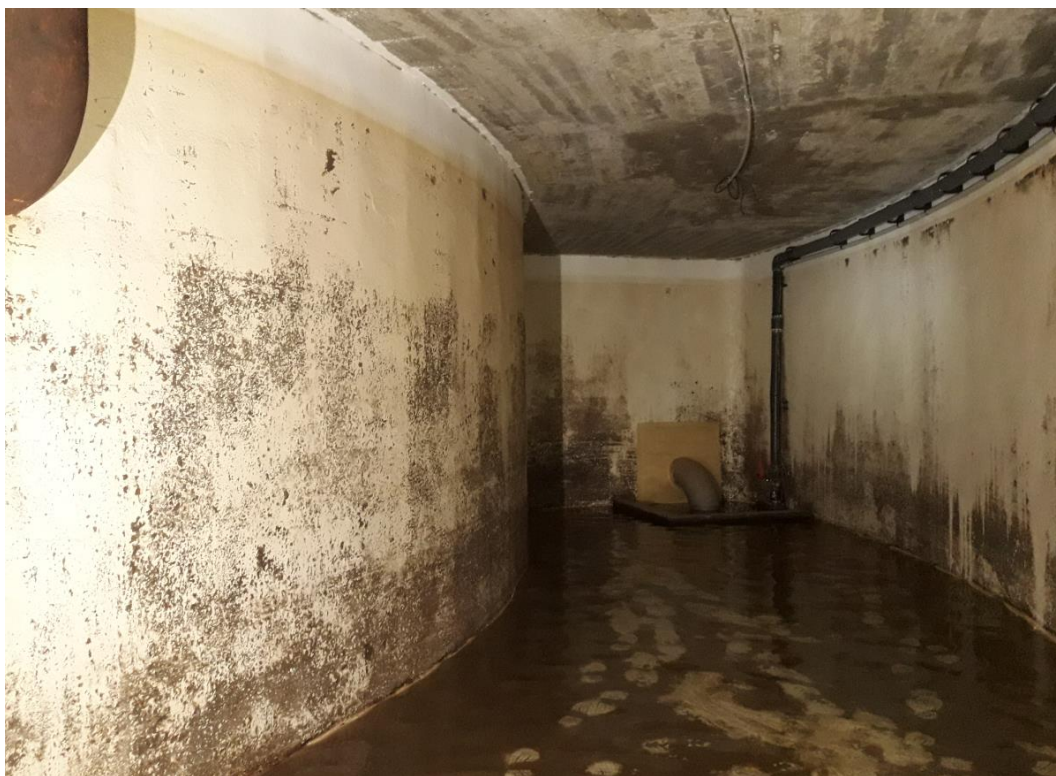
Photographie 39 : Désordres de type 4 et 6 – Dégradation de l'étanchéité et dépôt de ferrite
