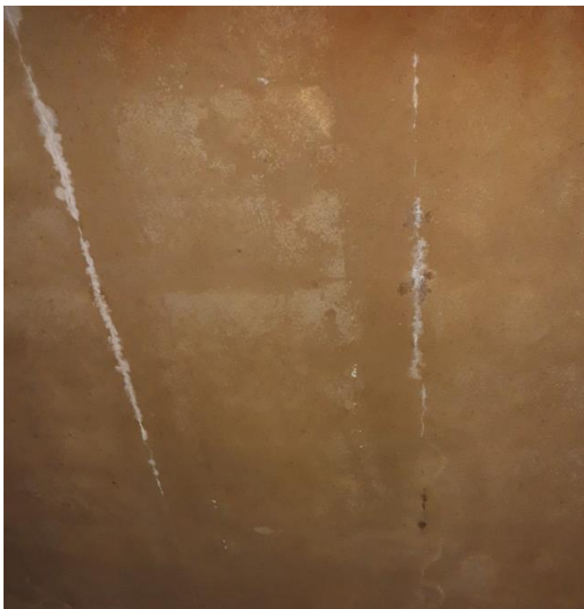
Photographie 48 : Désordres de type 2 et 3 – Fissure dalle haute de la salle d'aspersion
