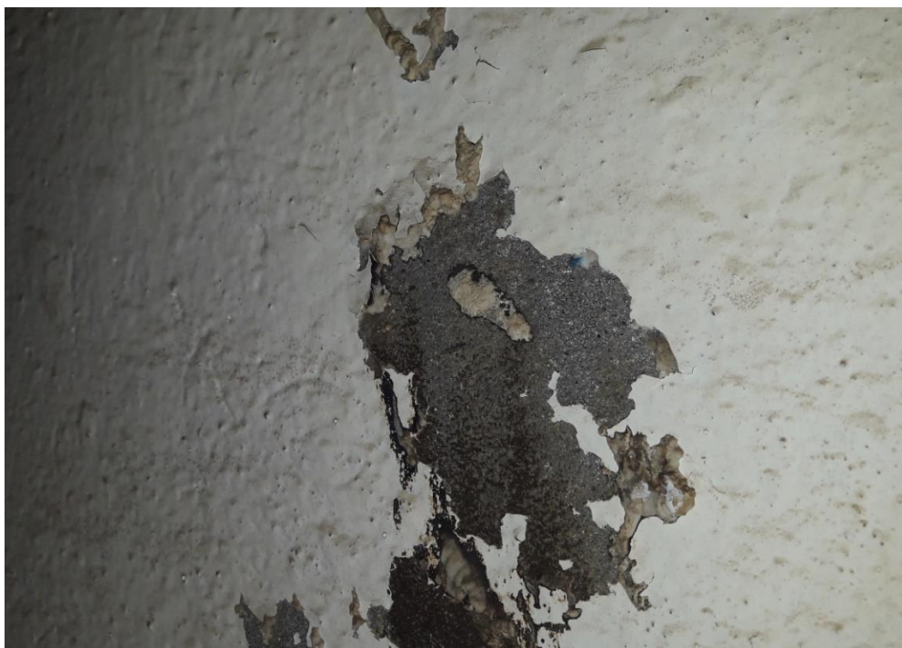
Photographie 41 : Désordre de type 4 – Cloquage et dégradation de l'étanchéité
