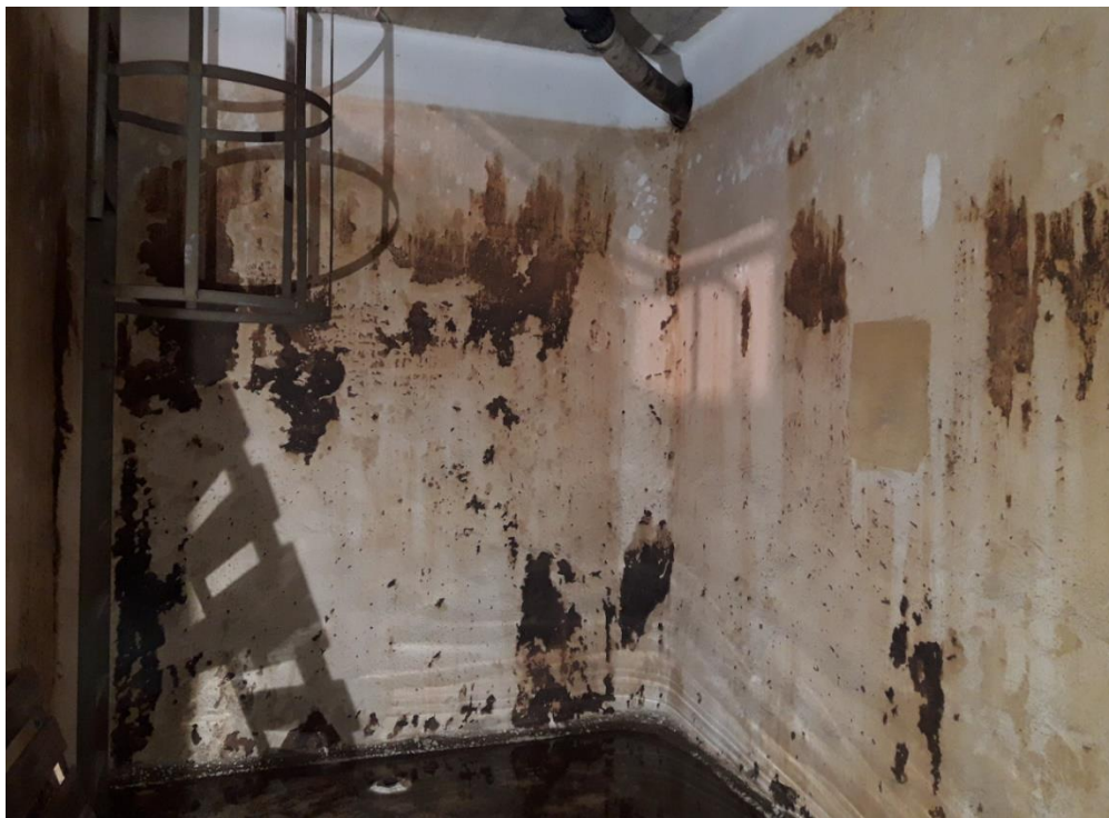
Photographie 52 : Désordres de type 4 et 6 – Dégradation de l'étanchéité et dépôt de ferrite
