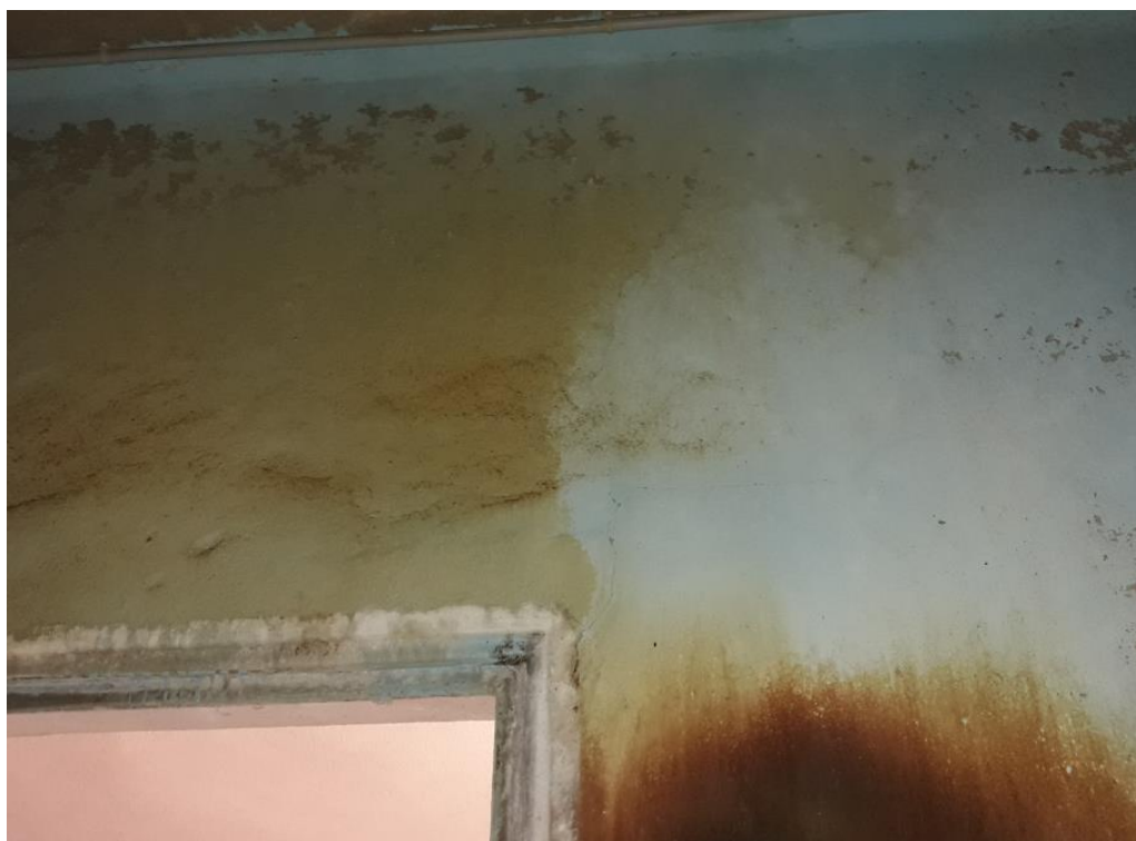
Photographie 47 : Désordres de type 3, 4 et 6 – Fissure angle ouverture
