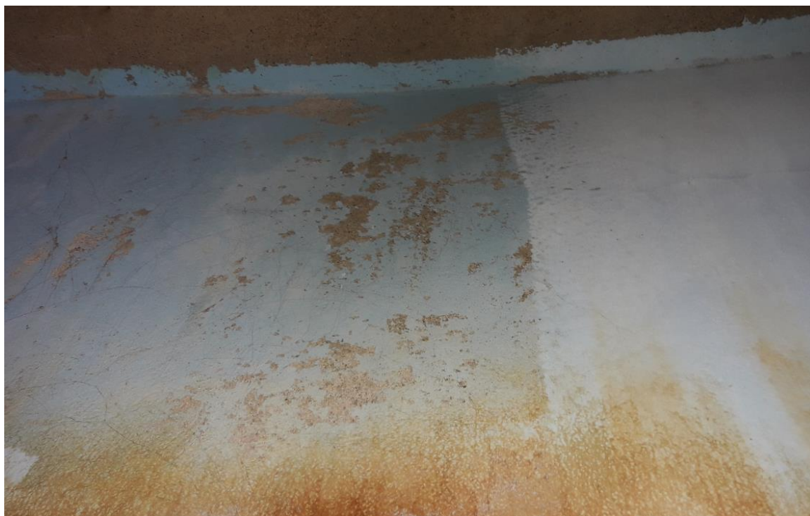
Photographie 70 : Désordres de type 4 et 6 – Dégradation de l'étanchéité et dépôt de ferrite
