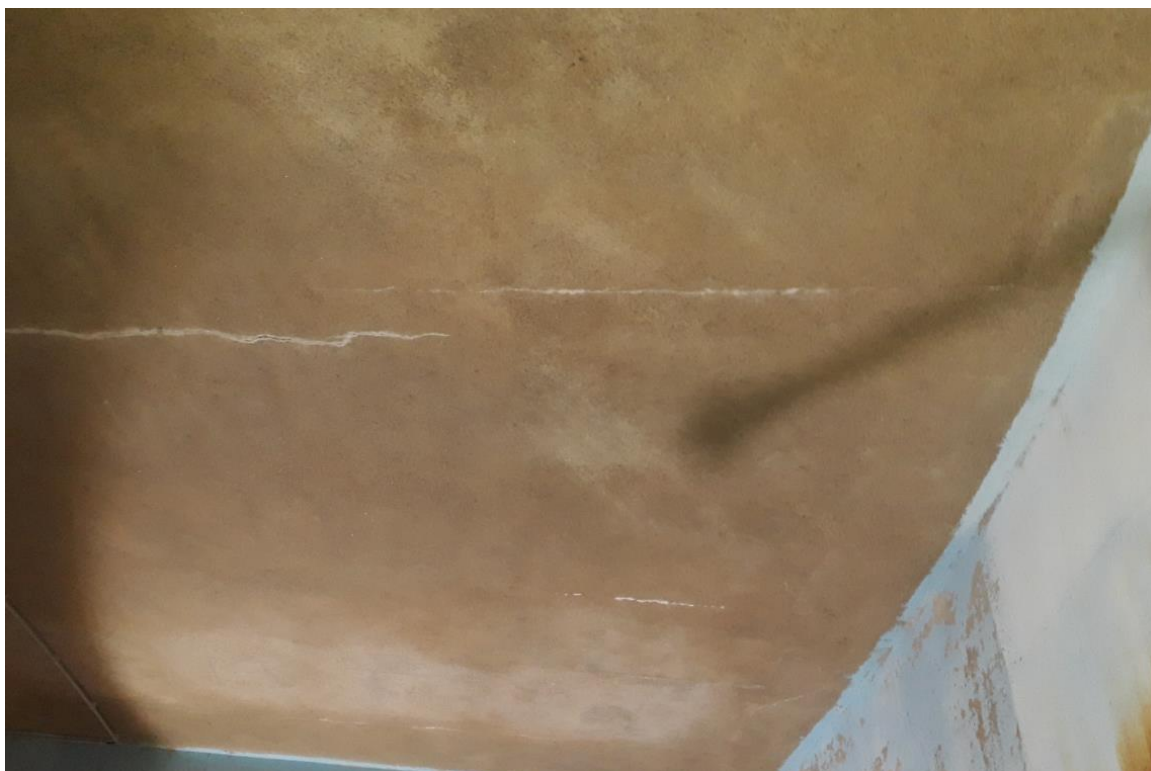
Photographie 65 : Désordres de type 2 et 3 – Fissures dalle haute et calcite
