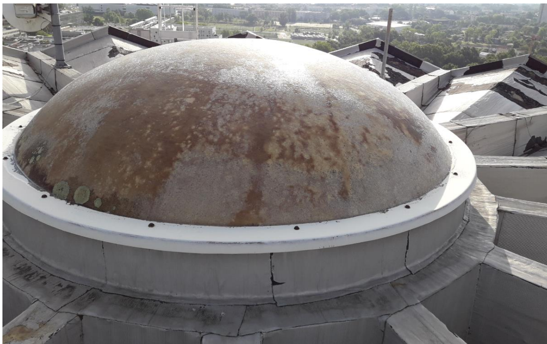
Photographie 92 : Désordre de type 4 - Vue de l'étanchéité en surface du toit du belvédère
