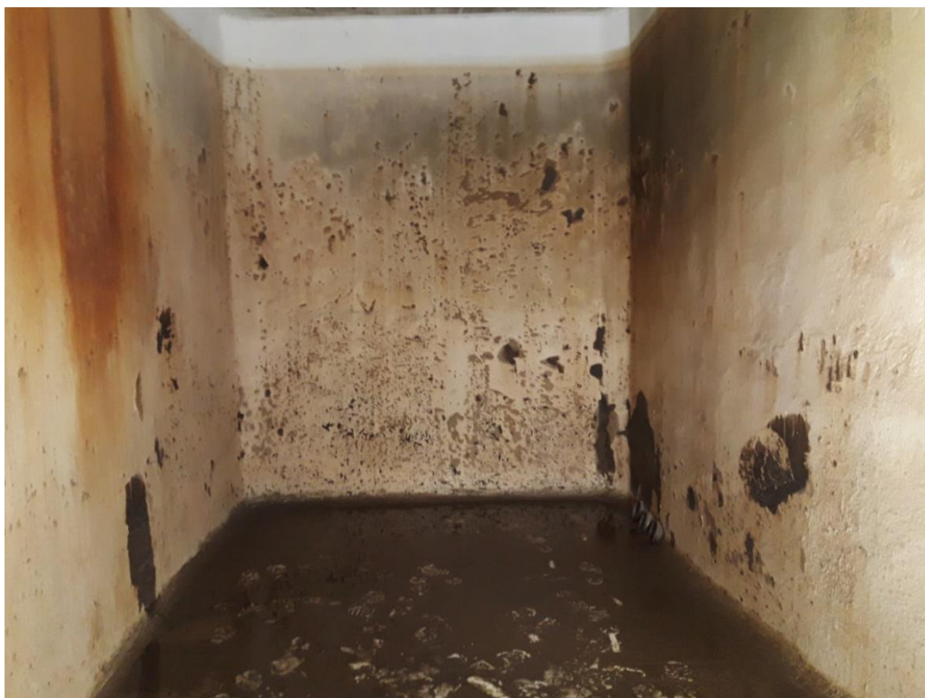
Photographie 54 : Désordres de type 4 et 6 – Dégradation de l'étanchéité et dépôt de ferrite
