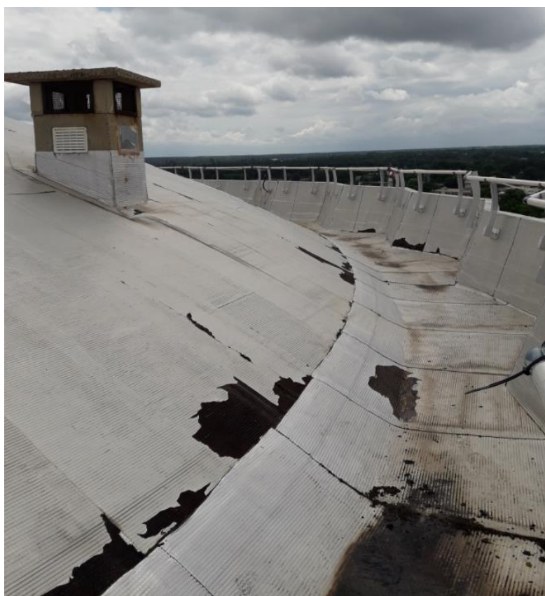
Photographie 83 : Désordre de type 4 - Vue de l'étanchéité en surface de la dalle haute de la cuve
