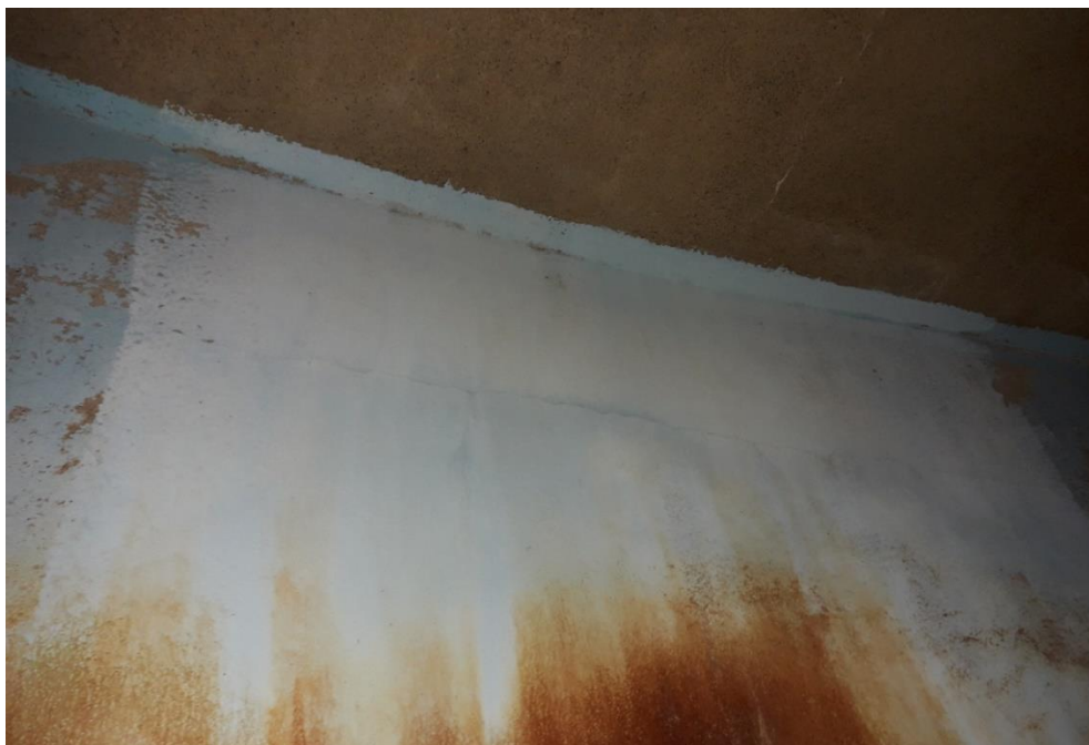
Photographie 63 : Désordres de type 3, 4 et 6 – Fissure horizontale et dépôt de ferrite
