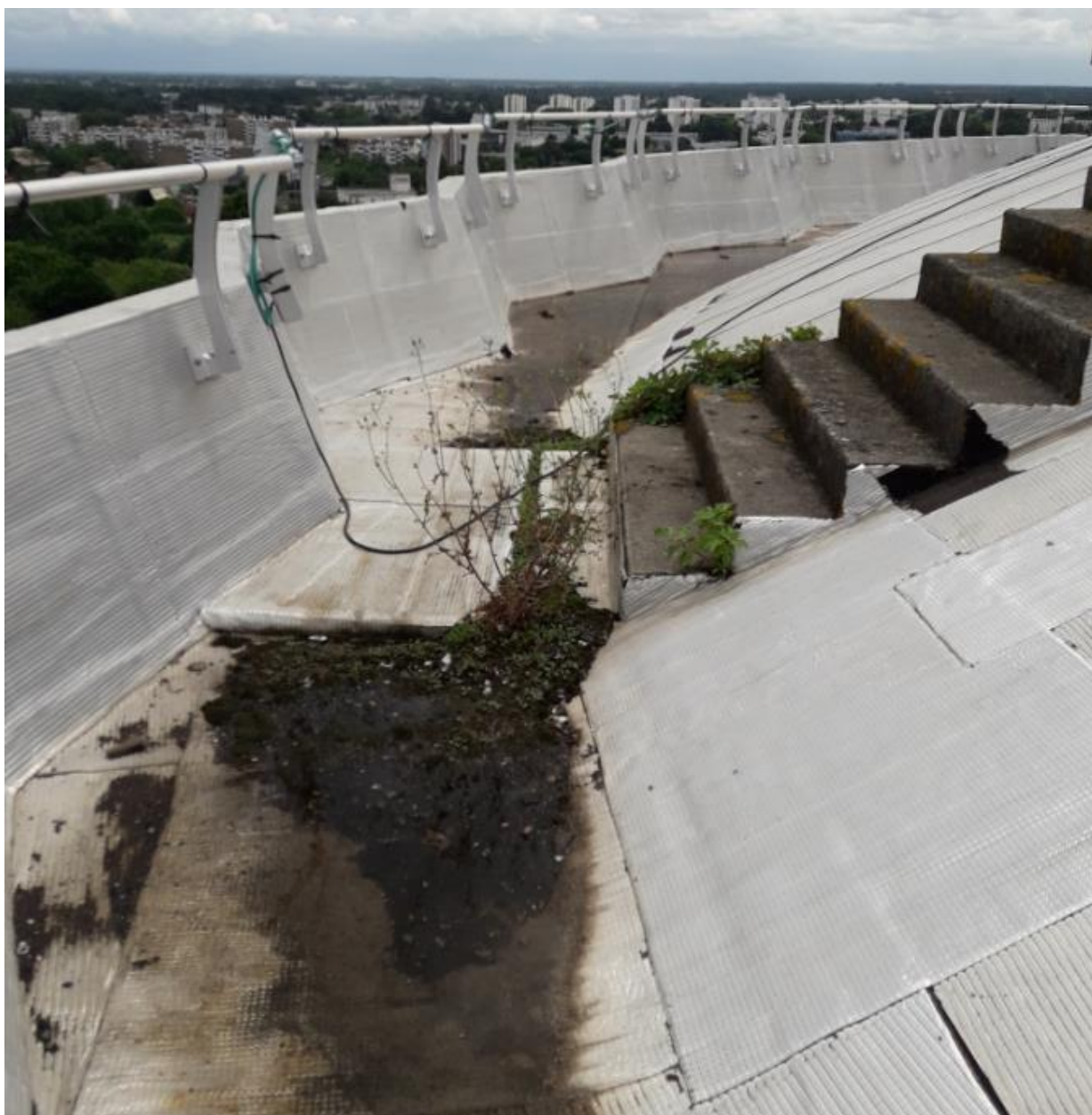
Photographie 87 : Désordre de type 4 - Vue de l'étanchéité en surface de la dalle haute de la cuve
