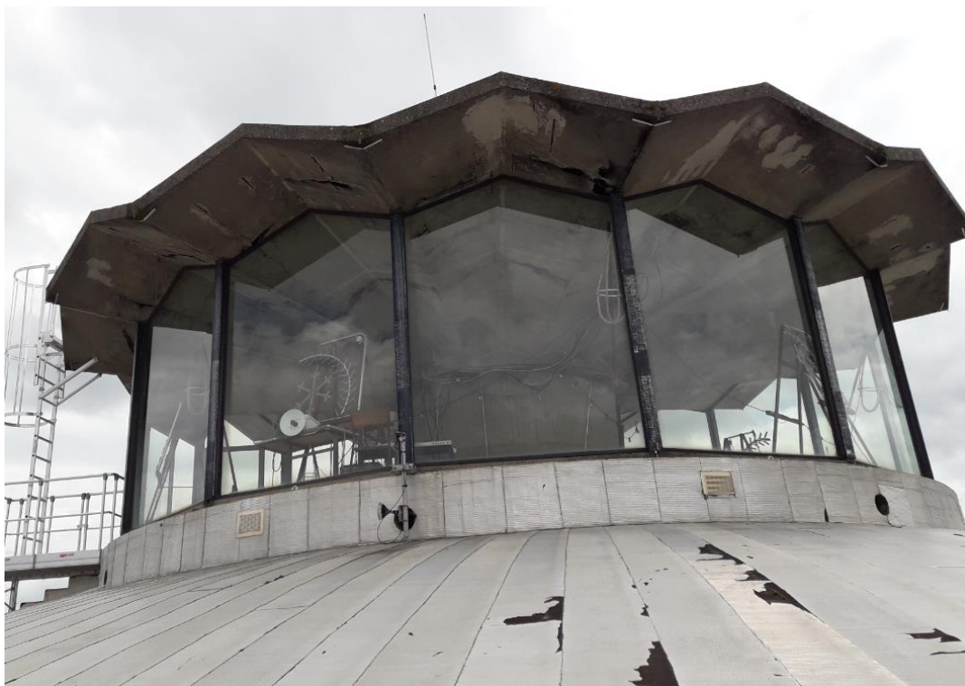
Photographie 82 : Désordre de type 4 - Vue de l'étanchéité en surface de la dalle haute de la cuve
