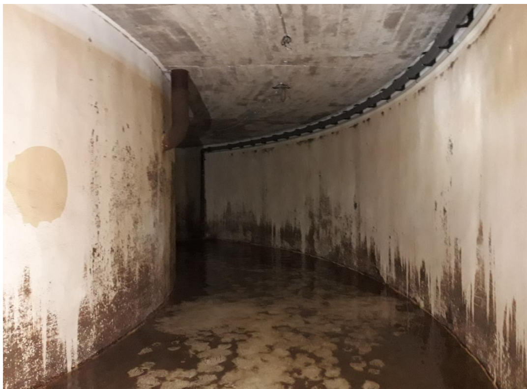
Photographie 38 : Désordres de type 4 et 6 – Dégradation de l'étanchéité et dépôt de ferrite
