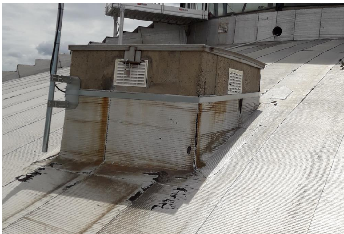
Photographie 86 : Désordre de type 4 - Vue de l'étanchéité en surface de la dalle haute de la cuve
