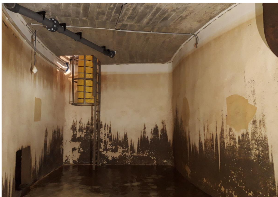
Photographie 40 : Désordres de type 4 et 6 – Dégradation de l'étanchéité et dépôt de ferrite
