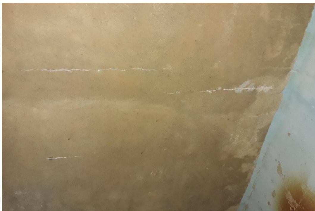
Photographie 49 : Désordres de type 2 et 3 – Fissure dalle haute de la salle d'aspersion
