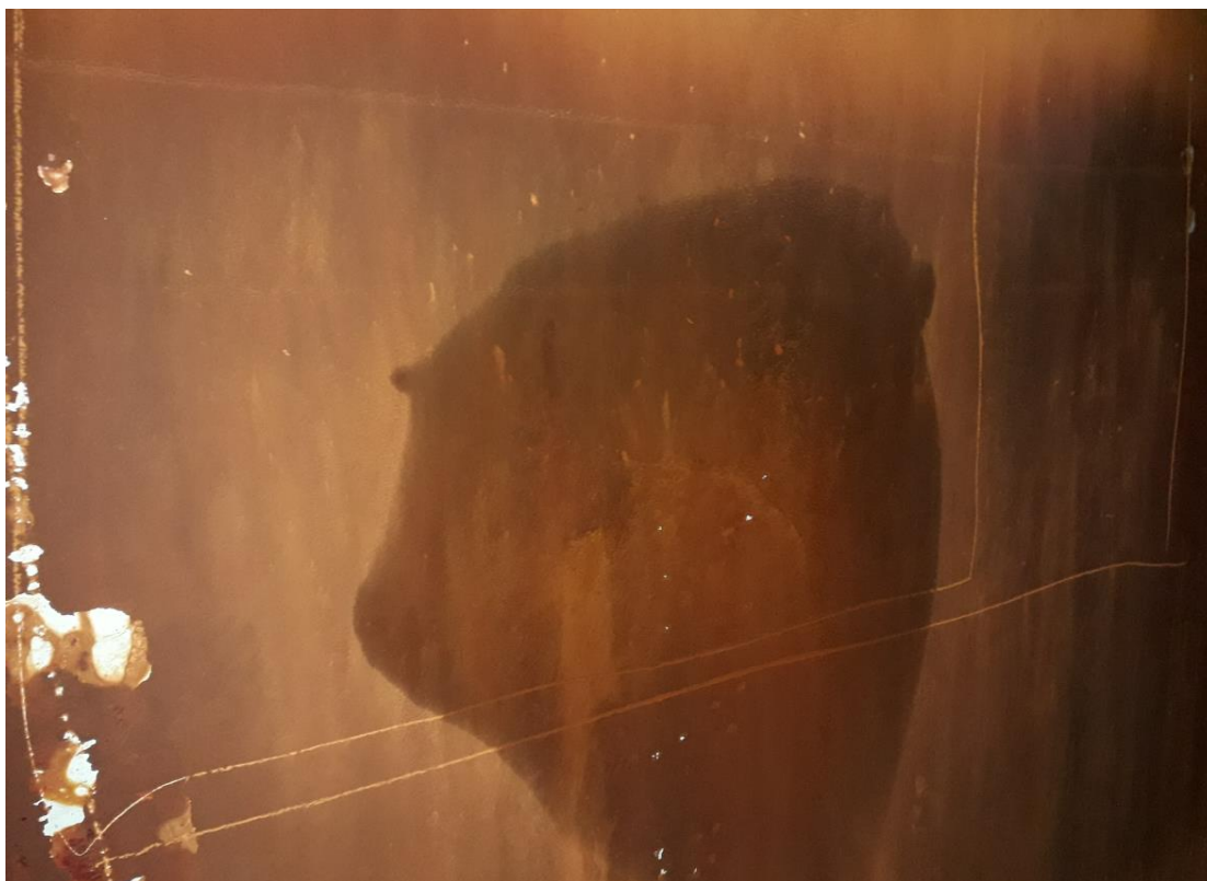
Photographie 69 : Désordres de type 4 et 6 – Cloquage de l'étanchéité et dépôt de ferrite
