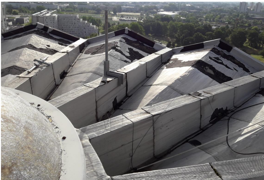
Photographie 88 : Désordre de type 4 - Vue de l'étanchéité en surface du toit du belvédère
