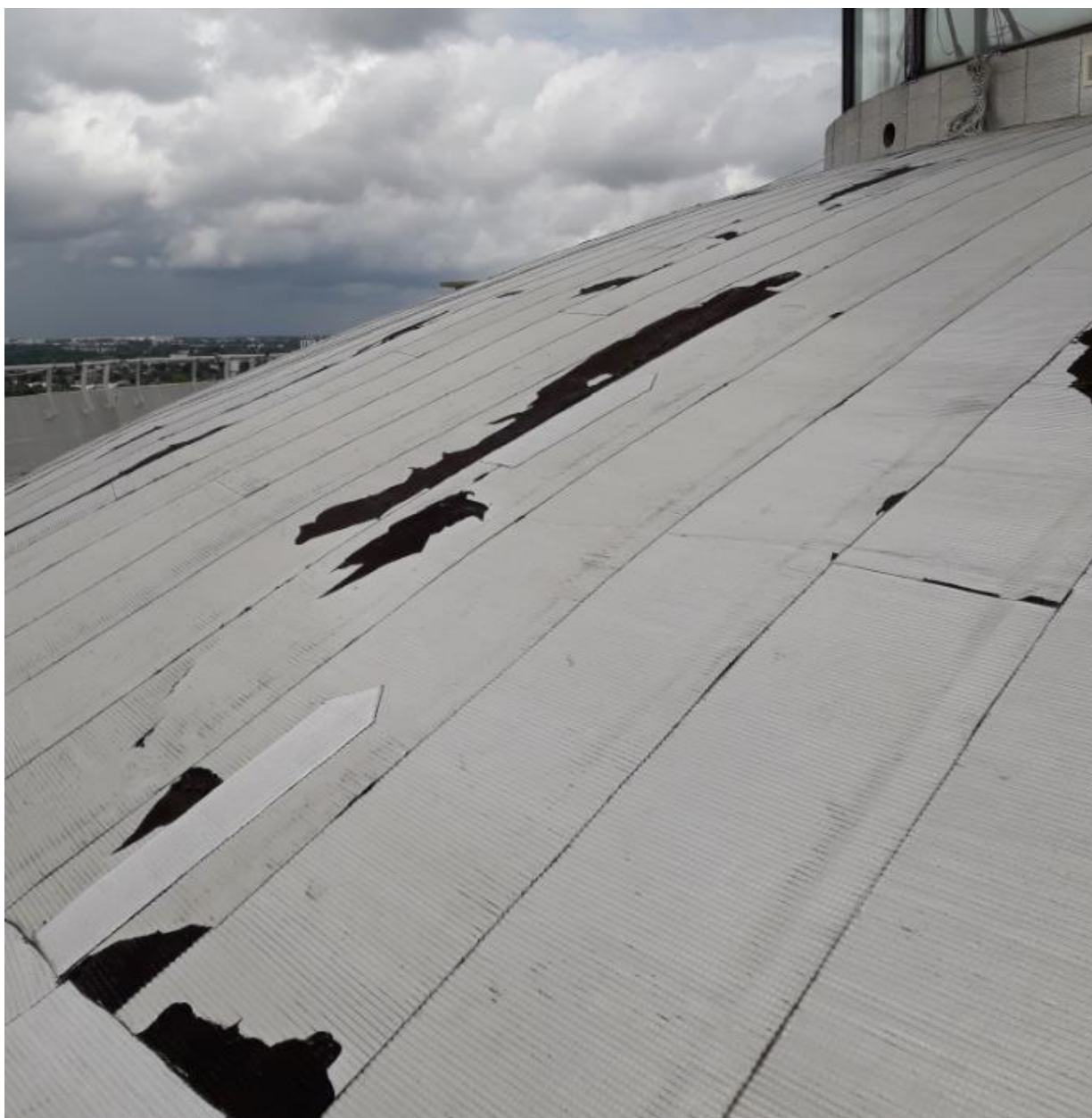
Photographie 84 : Désordre de type 4 - Vue de l'étanchéité en surface de la dalle haute de la cuve
