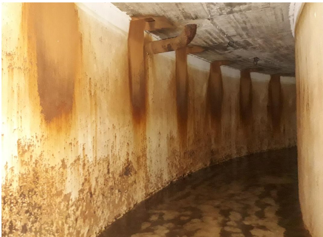
Photographie 37 : Désordres de type 4 et 6 – Dégradation de l'étanchéité et dépôt de ferrite
