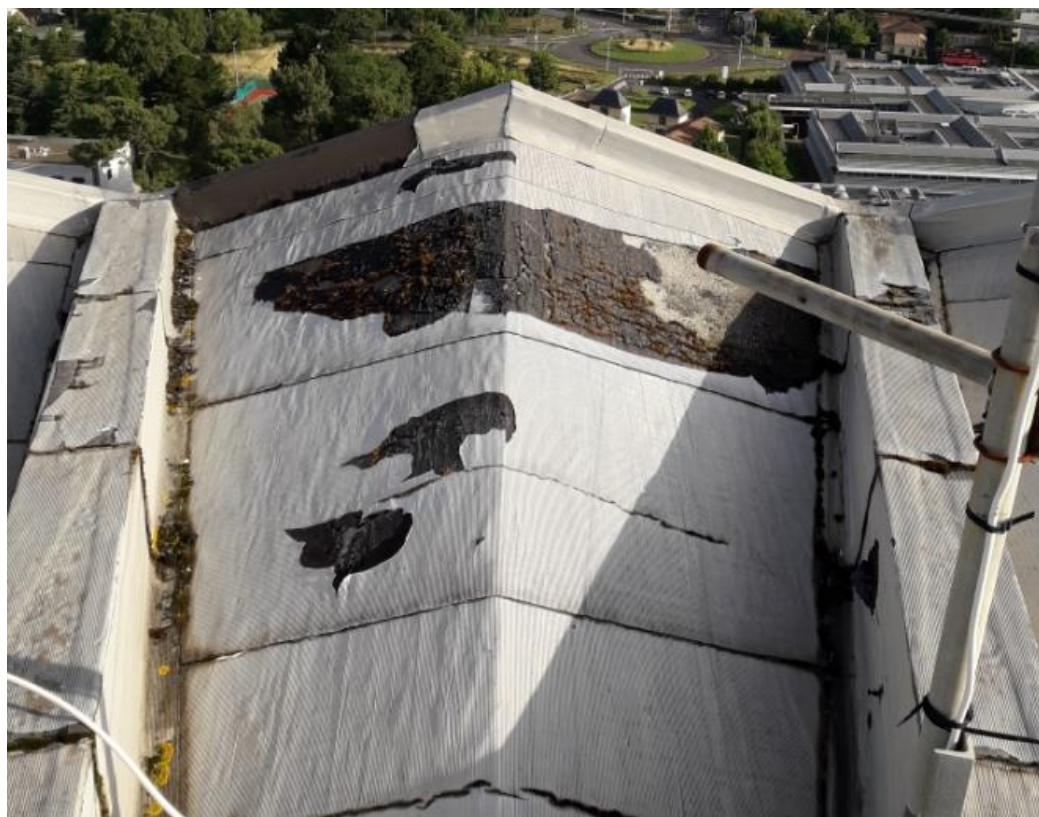
Photographie 91 : Désordre de type 4 - Vue de l'étanchéité en surface du toit du belvédère
