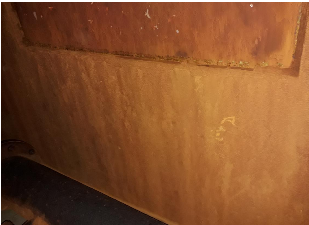
Photographie 51 : Désordres de type 4 et 6 – Dégradation de l'étanchéité et dépôt de ferrite
