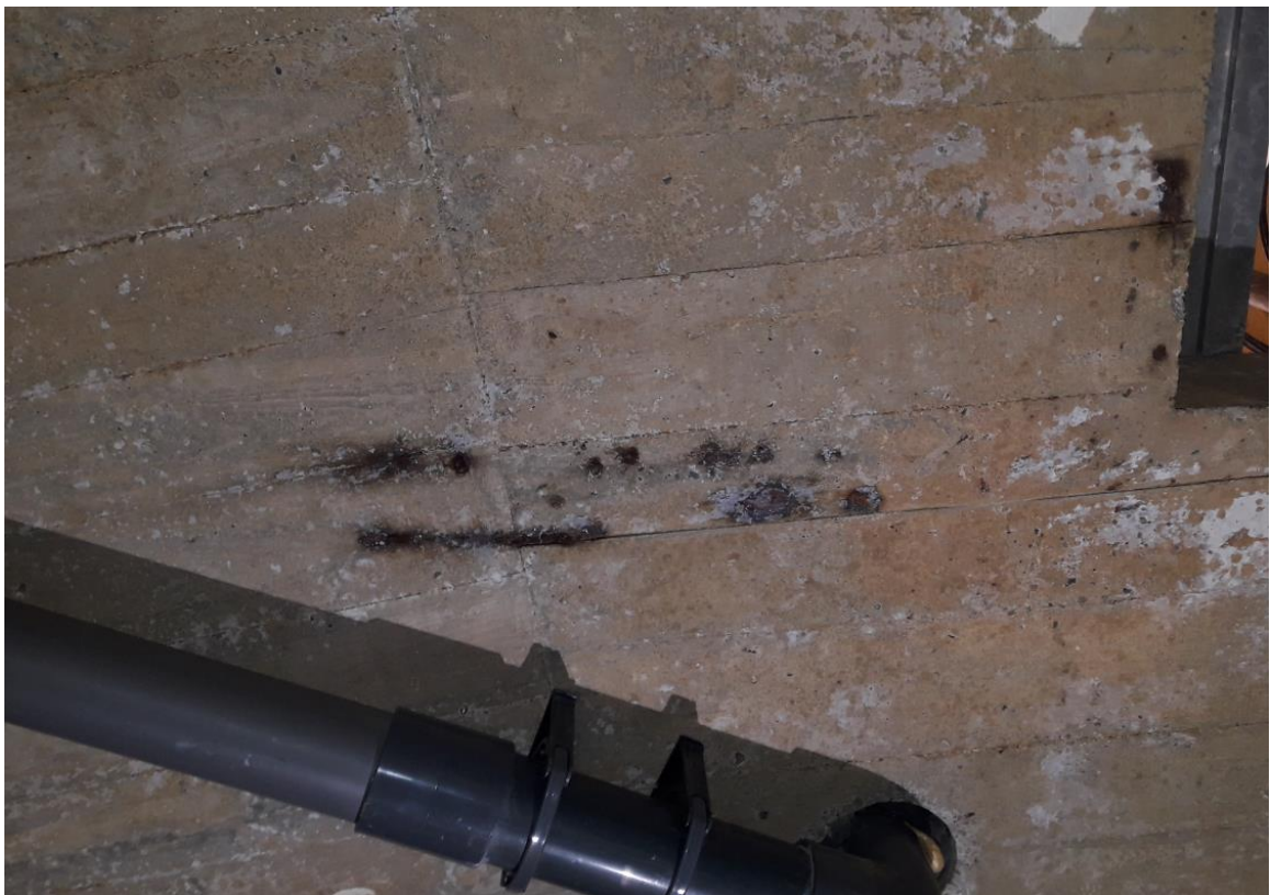
Photographie 60 : Désordre de type 1 – Dalle haute de la bâche
